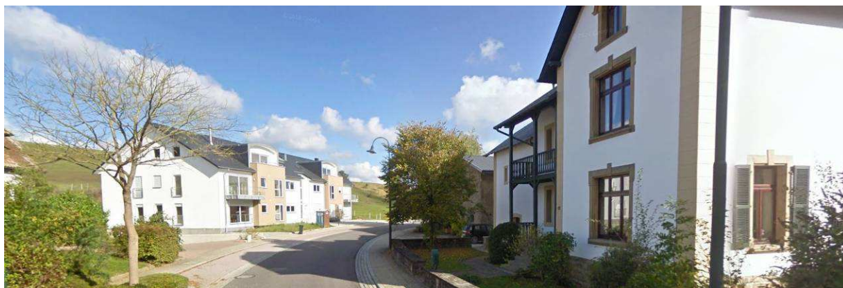
Maison plurifamiliale – Route de Luxembourg
