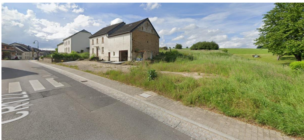
Figure 9: Vue depuis le CR122 sur la partie sud-est du projet (Source : Google Maps - Street View)
