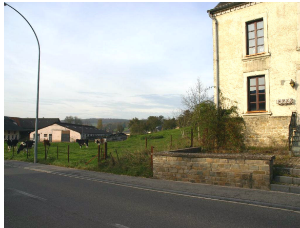
Figure 8 : vue depuis le CR122 sur le site
