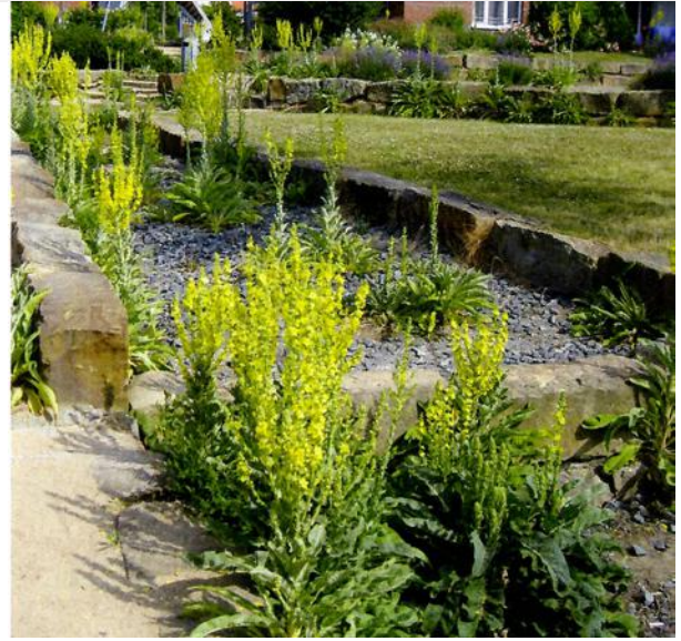
offene Retentionsgraben © Förder Landschaftsarchitekten
