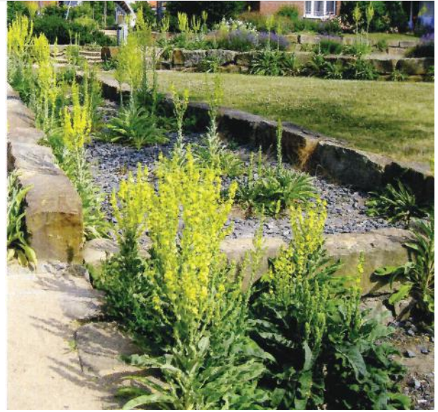
offene Retentionsgraben © Förder Landschaftsarchitekten
